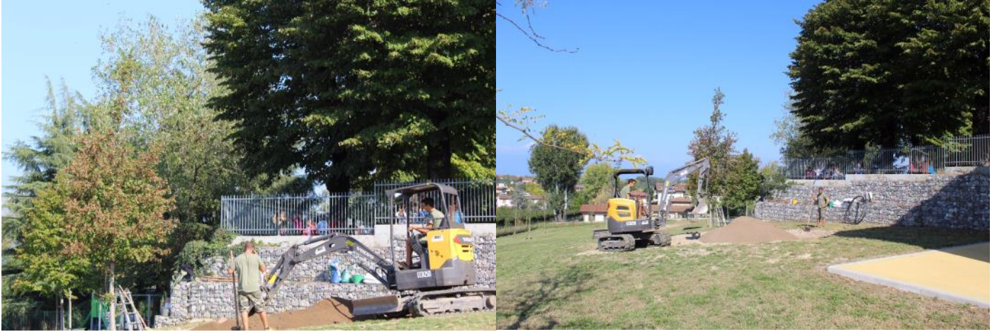
Lavori di preparazione per la piantumazione
