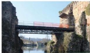
Fig. 1.30 Il ponte in ferro che è stato costruito alla fine degli anni '20 per ripristinare il collegamento tra le due parti del ponte. Il parapetto è provvisorio e dei tratti sono protetti con la rete di cantiere plastificata arancione.
