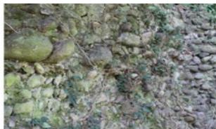
Fig. 1.27 Un tratto della muratura in ciottoli di grandi dimensioni. Si può notare come le radici della vegetazione siano entrate all'interno della muratura, rovinandola e rendendo difficili gli interventi futuri di restauro.
