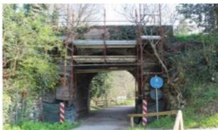
Fig. 1.26 Sottopassaggio della diga nei pressi della torre-porta est: le impalcature hanno la funzione di proteggere i passanti da eventuali crolli di materiale dall'alto. Le impalcature sono presenti da diversi anni.
