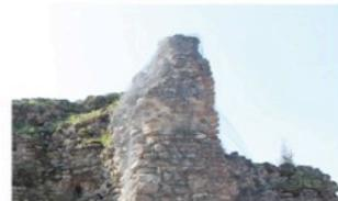
Fig. 1.31 Uno dei torresini meglio conservato lungo il ponte. La muratura è stata avvolta con una rete metallica in modo da scongiurare eventuali distacchi di materiale che potrebbero mettere in pericolo la sicurezza dei passanti.
