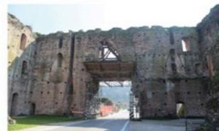
Fig. 1.34 Il manufatto centrale. Si nota l'intervento con putrelle in ferro per il sostegno della mancanza all'interno della muratura. Più recenti sono le impalcature con le mantovane per proteggere dalle cadute.
