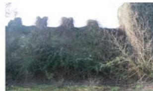
Fig. 1.28 Un brano delle superfici scarpate riprese dai prati verso Peschiera. La vegetazione ha invaso completamente la muratura, tanto che si riescono a fatica ad intravedere i ciottoli sottostanti.
