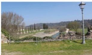
Fig. 1.32 Parapetti in ciottoli a lato del ponte visconteo. La vegetazione ha ormai aggredito la muratura che in gran parte è crollata. Delle transenne (facilmente rimovibili) impediscono la caduta delle persone.
