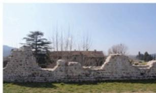
Fig. 1.33 Un tratto della muratura in ciottoli su cui è stato eseguito un intervento pilota da parte della Soprintendenza per il restauro del parapetto. La muratura è stata riportata ad un innaturale colore bianco.
